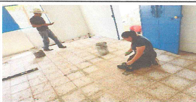
Foto 5: Sustitución de piso en la cocina, torta por piso granito
