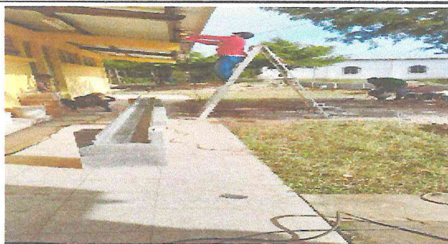
Foto 3: Colocando las bases para los canales
