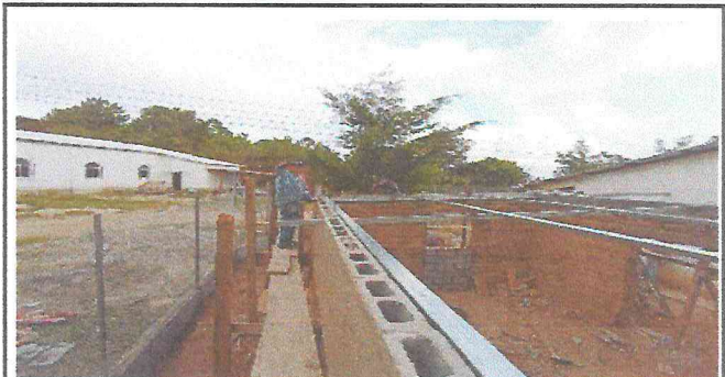
Foto 2: Colocación de block para ampliar la altura de las paredes
