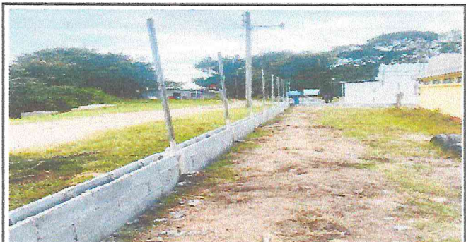
Foto 4: Colocación de block y U solera, fundida para la sustitución de cerco perimetral por muro perimetral con malla de 2 mts., de altura
