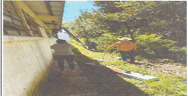
Foto 2: Quitando los canales de la parte de atrás de la escuela
