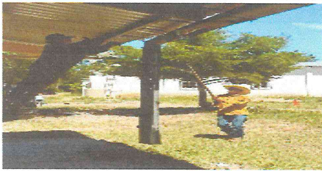
Foto 1: Quitando los canales del frente de la escuela
