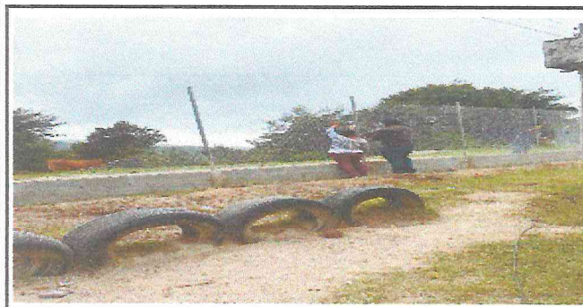
Foto 5: Colocación de malla de 2 mts., de altura con base de block
