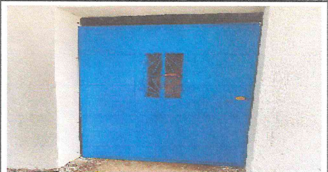
Foto 2: Sustitución de puerta de la cocina
