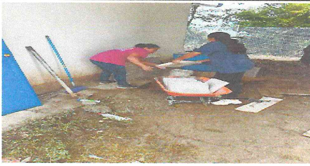
Foto1: Sustitución de pisos
