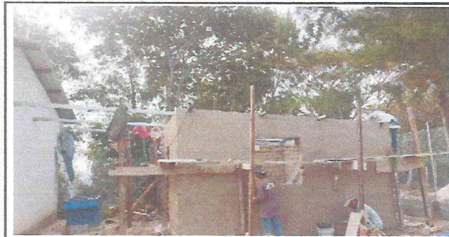
Foto 3: Sustitución de estructura de madera por estructura de metal
