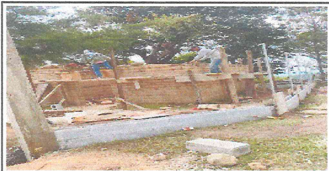
Foto 6: Preparando las paredes de la cocina para ampliar su nivel de altura
