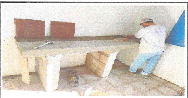
Foto 6: Elaboración de mesa fundida y colocación de azulejos
