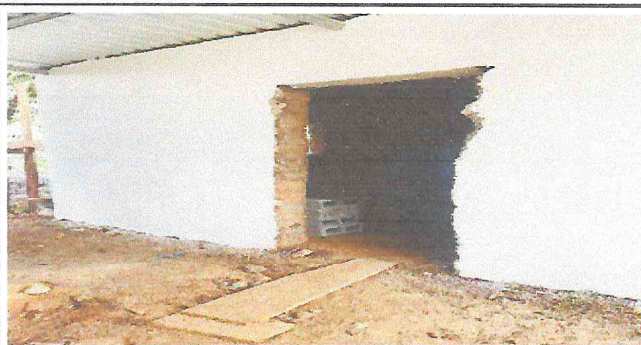
Foto 3: Sustitución de la puerta de la cocina
