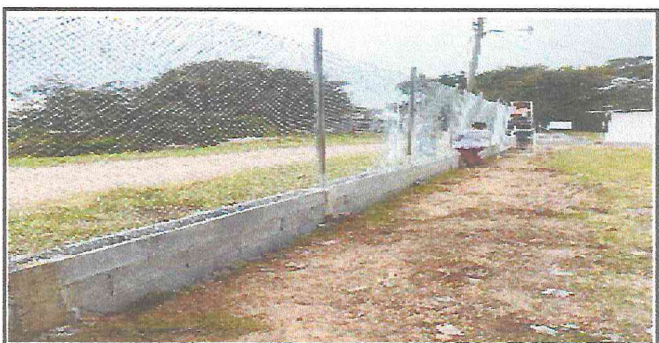
Foto 6: Colocación de malla de 2 mts., de altura con base de block
