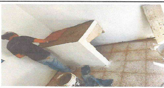
Foto 5: Elaboración de la hornilla e instalación de plancha comalera
