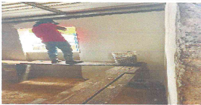
Foto1: Repello de las paredes por dentro
