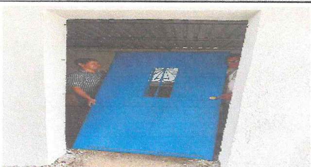
Foto 3: Sustitución de la puerta de la cocina
