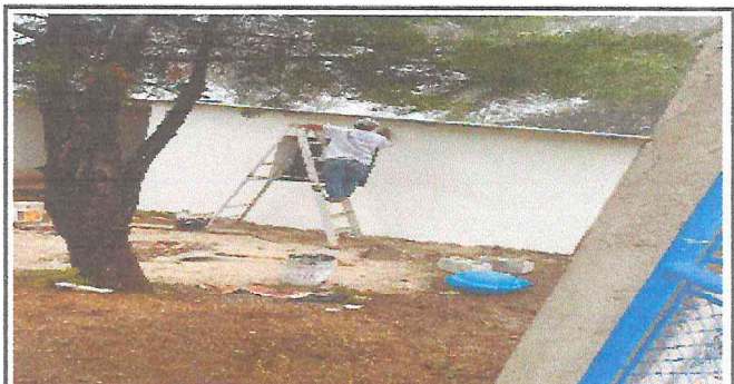
Foto 4: Repello de las paredes por fuera, segunda capa
